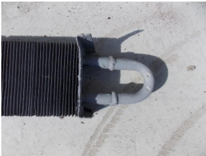
1.3 Установить на сварочном пистолете ACCU-TWIN расстояние между захватами 30...55 мм. Следуя инструкции к пистолету ACCU-TWIN, приварить шпильки М3 к калачу конвектора:
