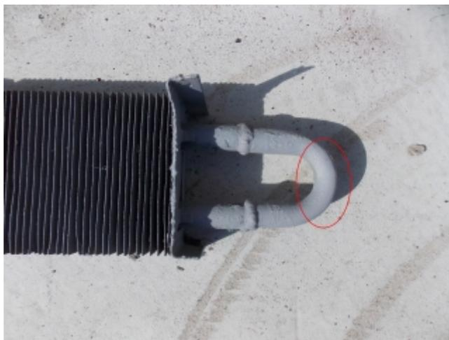
1.1 Определить места крепления приварных шпилек М3 (по центру калача конвектора). Расстояние между шпильками должно быть  $h=30...55$  мм :
