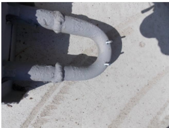
1.4 Зафиксировать стандартный тепловой адаптер, входящий в комплект поставки распределителя на приварных шпильках и закрепить при помощи двух гаек М3. Момент усилия затяжки гаек 50 сН·м.
